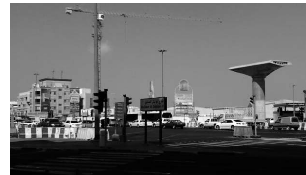
■道路のバイパス工事が進むドバイ市内の様子
